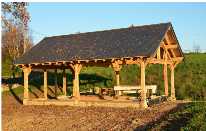
Restauration en cours du lavoir-abreuvoir de Montépín (Bâgé-Dommartin)
