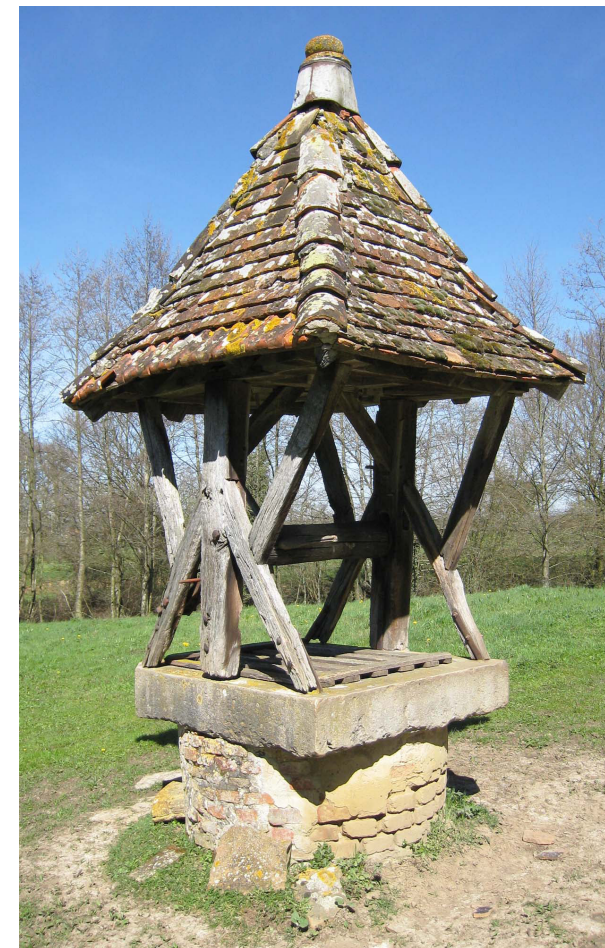
Puits de la Poype (Saint-Sulpice) - Propriété privée
